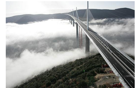
Viaduc de Millau
